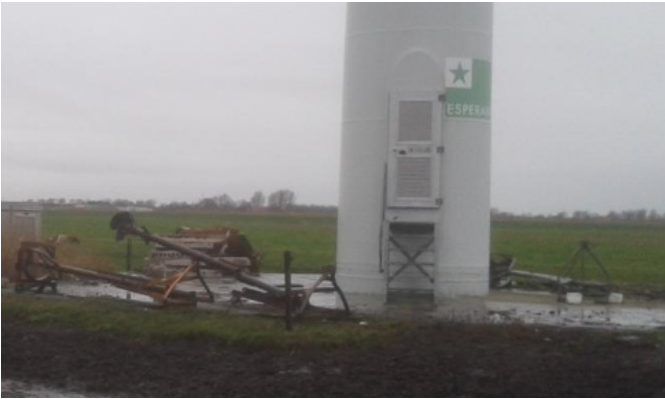
Esperanto-flago sur la piedo de ventoturbino.
